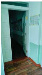
**17) наявна мнемосхема приміщення та шляхів руху із дублюванням інформації шрифтом Брайля, яка розміщена під кутом 20–30 градусів від горизонтальної площини, а нижній край якої розташовано на висоті 0,9 метра від підлоги, до якої веде тактильна смуга\***
