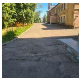
**6) покриття пішохідних доріжок, тротуарів і пандусів рівне (без вибоїн, без застосування як верхнього шару покриття насипних або крупноструктурних матеріалів, що перешкоджають пересуванню осіб з інвалідністю на кріслах колісних або із милицями)**
