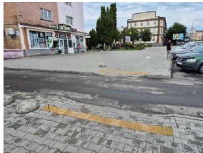
**6) уздовж пішохідної доріжки наявні зовнішні стандартні тактильні направляючі: бордюрний камінь, газон, пішохідна доріжка, яка має з одного чи двох боків різне за фактурою покриття із стандартних матеріалів, комбіноване покриття, коли на пішохідних шляхах покладені різні типи тротуарної плитки, бруківки, асфальту, що відрізняються тактильно і за кольором**
