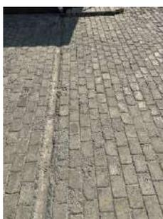
**6) покриття пішохідних доріжок, тротуарів і пандусів рівне (без вибоїн, без застосування як верхнього шару покриття насипних або крупноструктурних матеріалів, що перешкоджають пересуванню осіб з інвалідністю на кріслах колісних або із милицями)**
