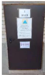
**7) забезпечено візуальний контраст дверей, а за наявності прозорих дверних (фасадних) конструкцій на них нанесено контрастне маркування кольором на висоті 1 метр – 1,5 метра\***
