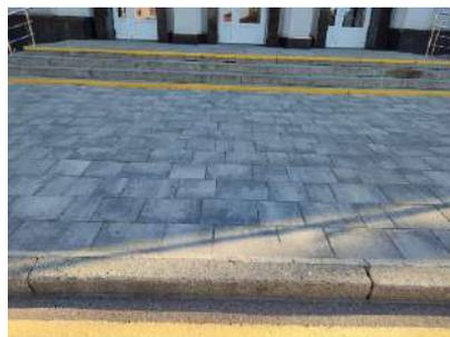
**12) перед перешкодами, що становлять небезпеку для осіб з порушенням зору, а також паралельно до сходів, перед і після сходового маршу розташована попереджувальна тактильна смуга\***
