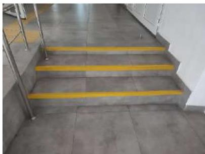
**4) перед перешкодами, що становлять небезпеку для осіб з порушенням зору, а також паралельно до сходів, перед і після сходового маршу розташована попереджувальна тактильна смуга\***
