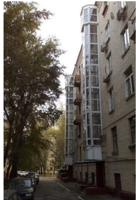
Рисунок 1.32. Приклади прибудови ліфта до сумісного зі сходовою кліткою приміщення
