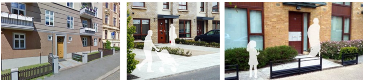
Рисунок 1.4. Приклади забезпечення входу в будинок з рівня вимощення Вхідні двері
