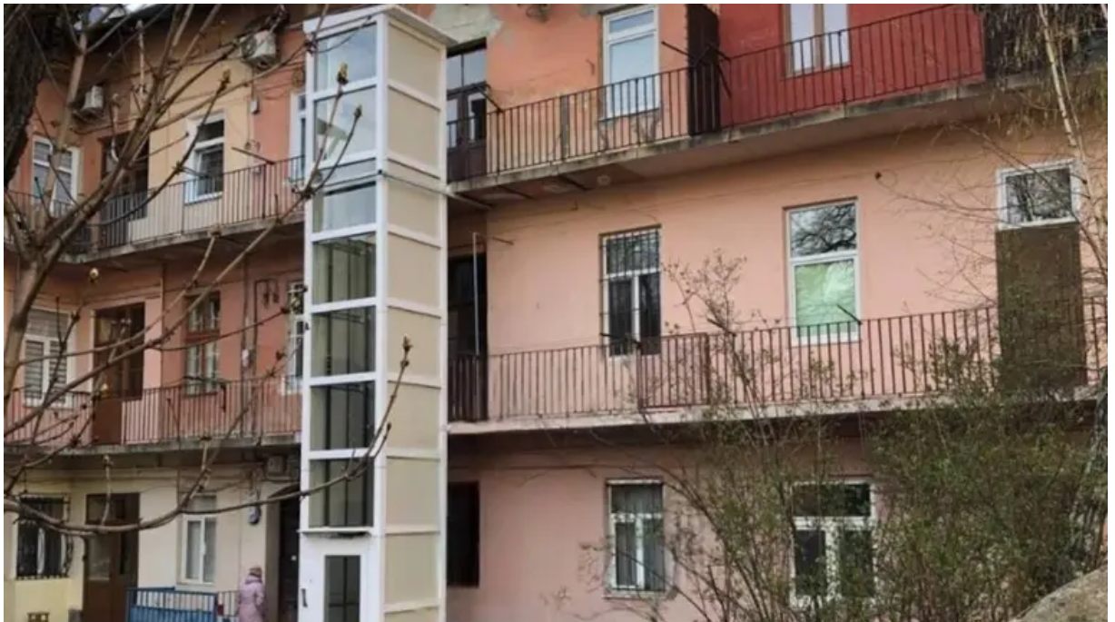
Рисунок 1.33. Приклад прибудови ліфта до галереїного будинку
